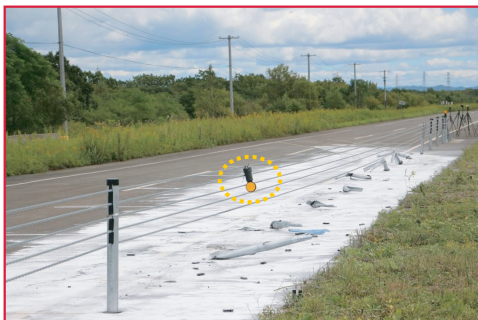
●試験車両衝突後の防護柵の状況
